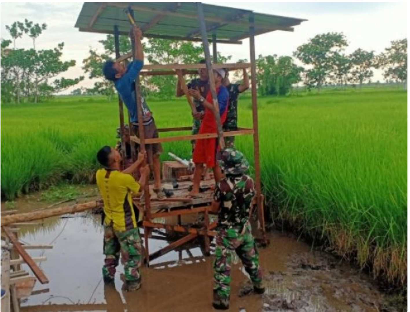
Pemasangan Atap WC
